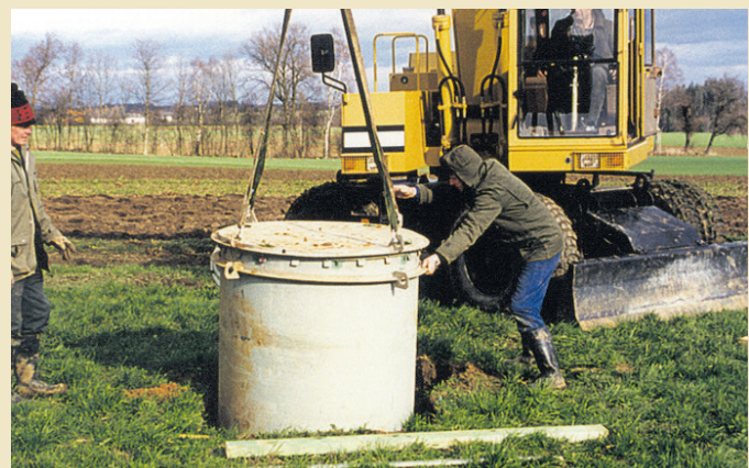
Abb. 1: Einbau des Lysimeters.
