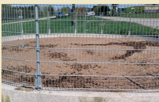
Abb. 2: Ab 2028 dürfen bei Tierhaltern mit mehr als 240 m 3 gesamtbetrieblichem Güllelageraum die Schwimmdecken maximal zwei Mal im Jahr aufgerührt werden. BWSB/Hölzl
