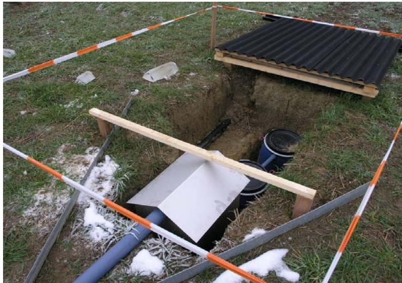
Abb. 18: Ableitungsbleche, geöffnete Überdachung
