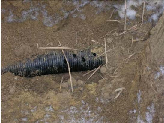
Abb. 21: gelochtes Drainagerohr
