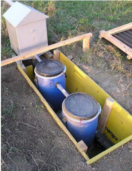
Abb. 24: Messeinrichtung nach erfolgter Abstützung der Grubenwände
