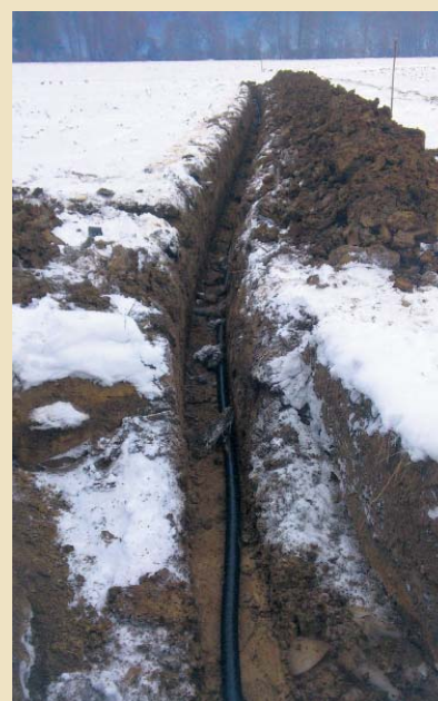
Verlegung eines Drainagestrangs. Fotos: Gabriel
