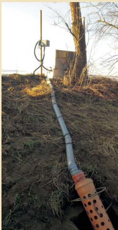
Messvorrichtung an einem Drainageauslass.
