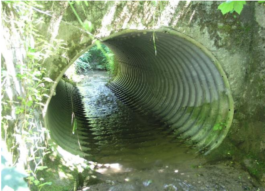
Abbildung 16 Maulprofilrohr an der Messstelle Asböckbach 1 (MSI)
